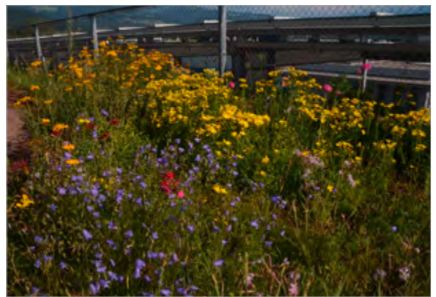
Naturnahe Dachbegrünung. Konsequenterweise sind alle Dächer der Betriebsgebäude mit Wildblumenansaat versehen. Auf einigen befinden sich sogar Aufenthaltsbereiche, Spazierwege und Sitzplätze.
